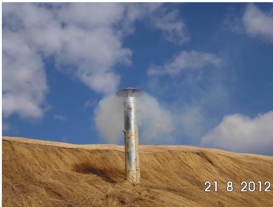
Fotografía 8: Detalle de la instalación de la chimenea.
