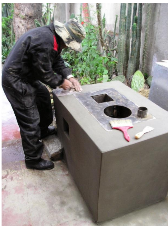
Fotografías 2 a 4: Fabricación de la plancha metálica, construcción de una cocina DULECO con adobes y estado final de la cocina con revoque.
