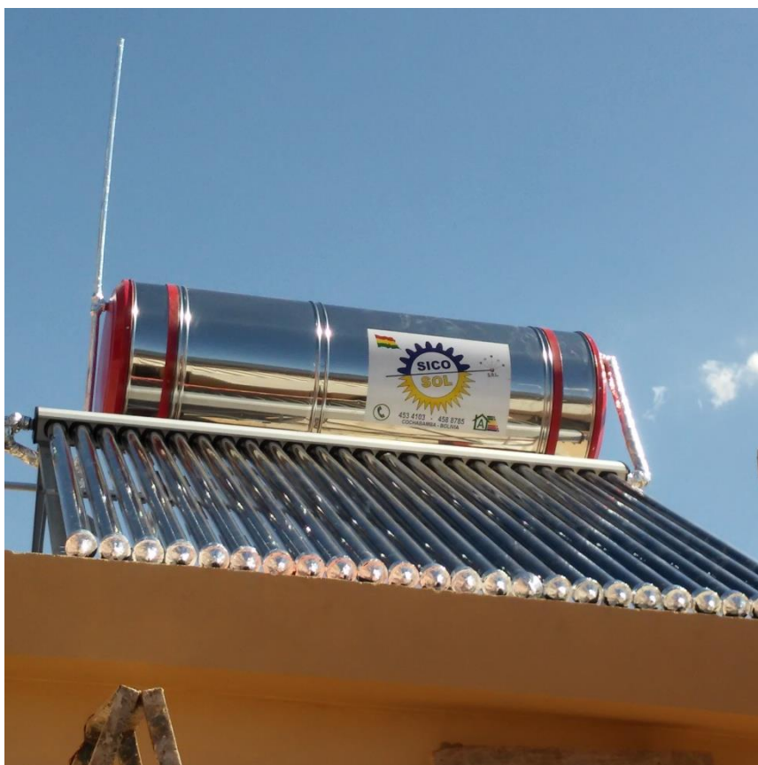
Figura 6. Calefón Solar de Tubos al Vacío – Sistema HEAT PIPE. Capacidad: 300 litros.
