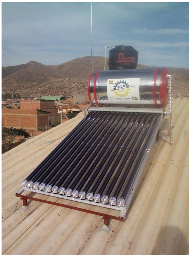
Figura 1. Calefón Solar de Tubos al Vacío – Sistema HEAT PIPE. Capacidad: 200 litros.
