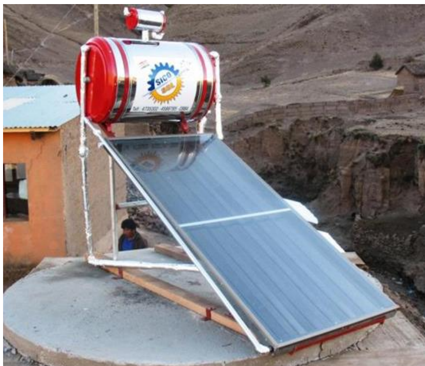
Fotografía 1: EQUIPO SICO SOL MODELO SS-200 para zonas frías. Encima del termo tanque se puede ver el tanque de expansión.
