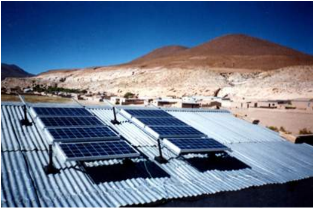
Instalación de un sistema fotovoltaico en el Altiplano Sur de Bolivia.
